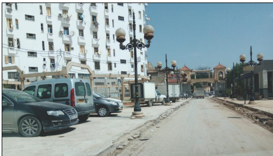
Figure 78: espace de repos envahie par le stationnement
