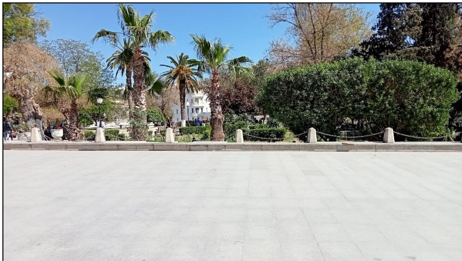
Figure 73: des potelets en granite posé sur muret et des chaines en acier placé à la place du mur démoli.
