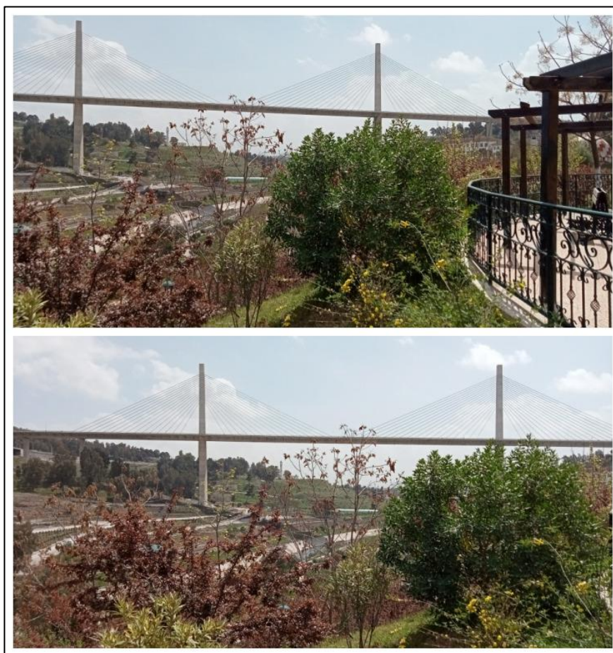
Figure 85: une vue qui rassemble le viaduc TransRhummel, le parc et Oued Rhumel
