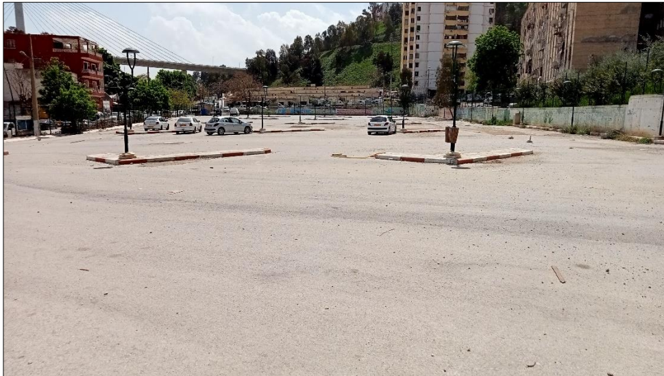
Figure 86: le parking du parc non aménagé encore d'une capacité de 600 places.
