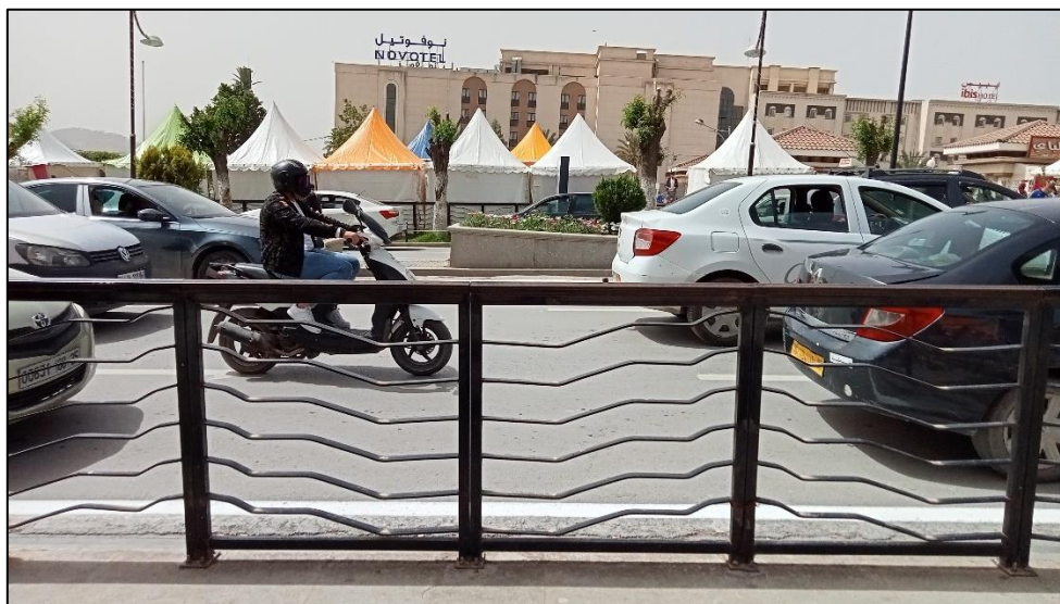
Figure 75: garde-corps en ferronnerie avec traverses intermédiaires en fer plat.
