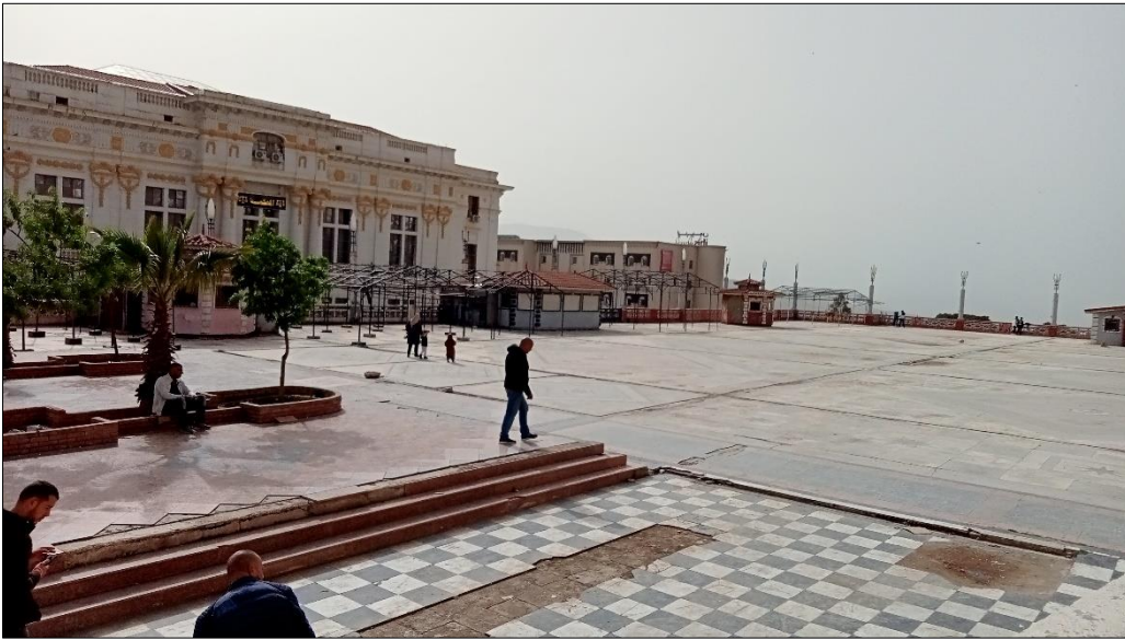
Figure 67: une esplanade vide et détériorée.
