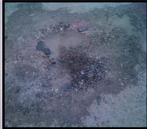
الصورة رقم 37 : تسربات في قنوات الصرف الصحي و مياه الشرب في قطاع طريق سدراته
