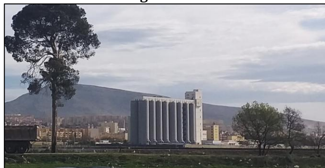
Fig. N° 118 : Silos de stockages des céréales -CCLS - El Khroub
