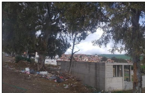
Fig. N° 112 : Problème de déchets AS Zaghrour Larbi dans la commune de Hamma Bouziane :
