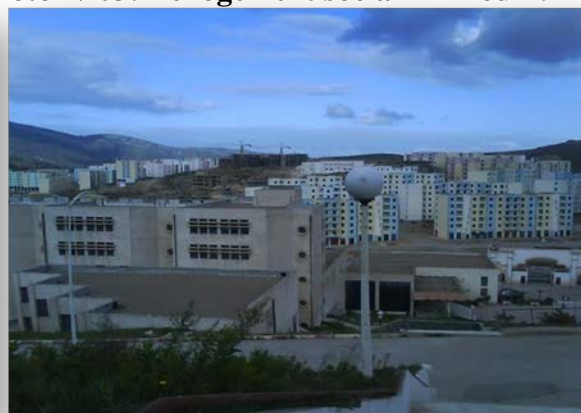
Photo N°03: Le logement social- El Bouni.
