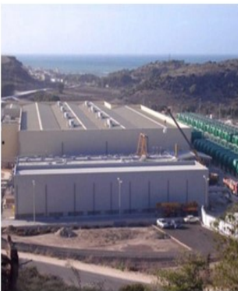
Usine de HONAINE
