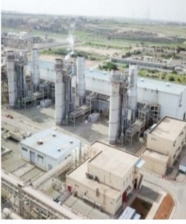
Usine de KAHRAMA
