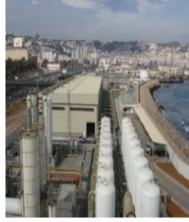
Usine de HAMMA
