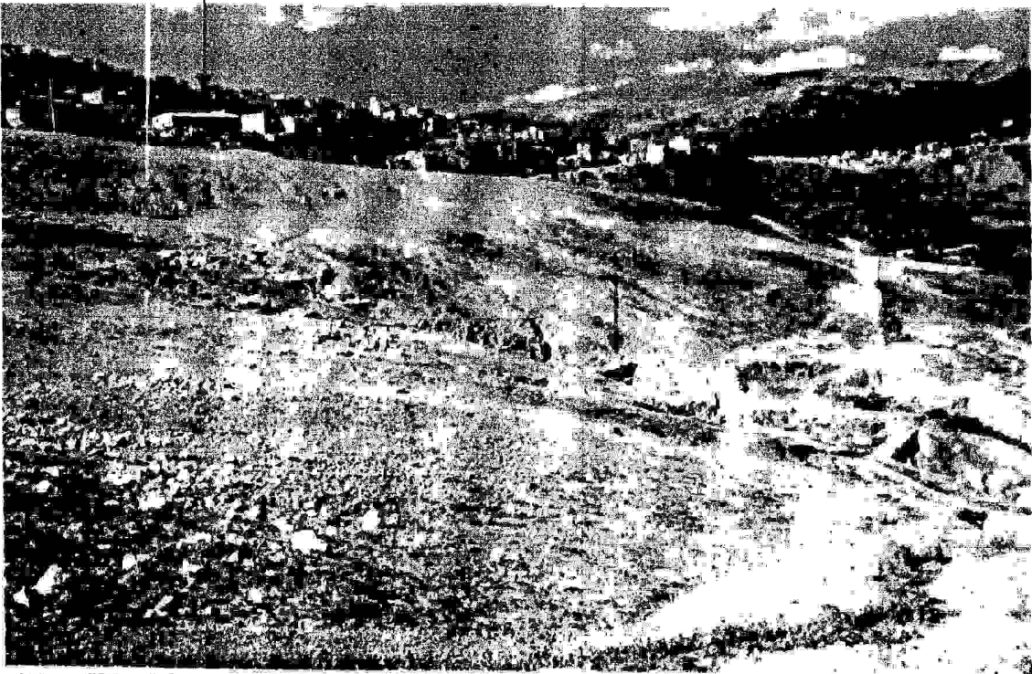
Fig - III - 16-B- Remblai du terrain Amirouche, en aval de la route du 20 août Le ravinement est freiné par des gabions transversaux. (GB).
