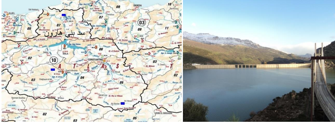
صورة 01: موقع سد بني هارون
