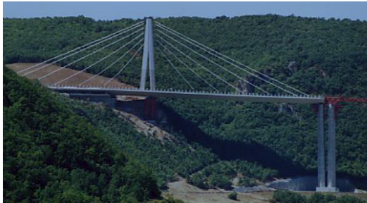
(a) Structures du génie civil
