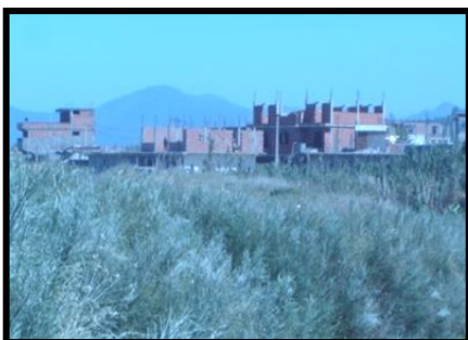
Photo n° 38: Des constructions illicites en dur à plusieurs étages, devant le silence et le laisser faire des collectivités locales
