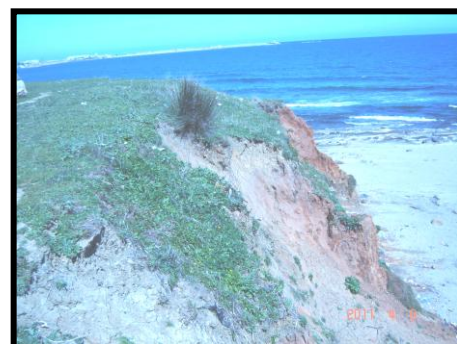
Photo n° 74: glissement de terrain près de la plage
