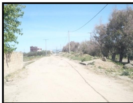
Photo n° 87: Les pistes non revêtus et les poteaux d'électricité dans la ZET
