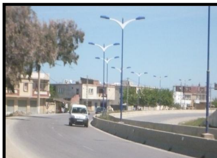
Photo n° 39: Des constructions illicites en dur avec du commerce aux RDC, sur la facade de la RN 43.
