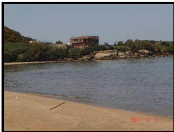
Photo n° 94: la partie rocheuse à l'extrémité Ouest de la ZET occupée par deux maisons individuelles en voie de s'augmenter en hauteur
