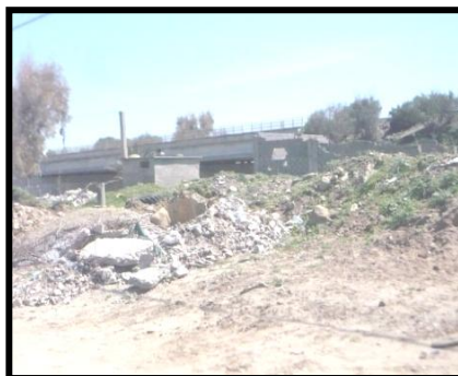
Photo n° 73: Rejets des matériaux de construction qui nécessite une décharge spéciale selon la loi 01-19.
