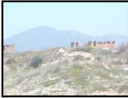
Photo n° 55: Habitats en dur non achevés et sans finition dont les poteaux sont construits mais ils ne sont pas dallés.
