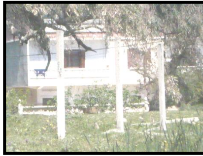
Photo n° 56: Habitat en dur fini, dont les balcons sont décorés en plâtre.
