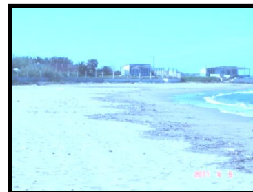
Photo n° 32: Bungalows et cafétéria à l'ouest de la ZET.
