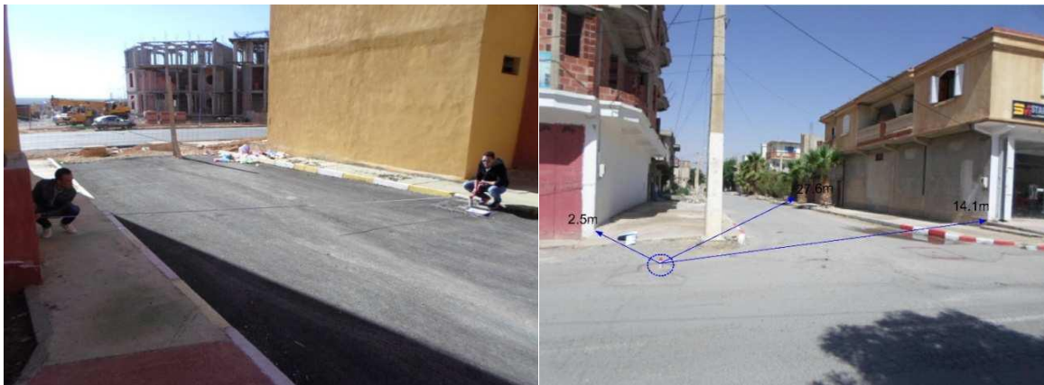
Figure. 5 : Photos Illustrant es travaux de triangulations des vannes
