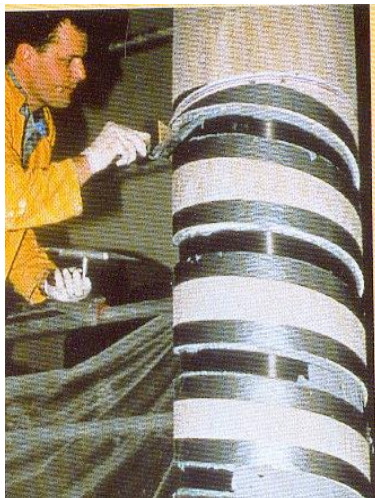
a) Colonne partiellement enveloppée par des bandes PRF en spirale continue.
