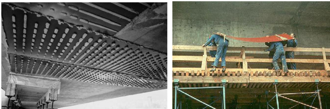
Figure I - 10 : Tôles collées ; (droite) difficulté de manutention ; (gauche) Renforcement du viaduc de Terrenoire par tôles collées perforées (Freyssinet) [tech ing3].
