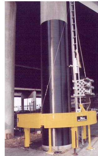
c) Robo Wrapper (L'enroulement filamentaire) (CRC, 2002)
