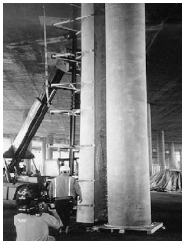
b) Mise en place d'une coquille en FRP (NCHRP, 2004)
