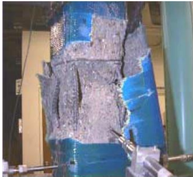
Figure V - 8 : Rupture du renfort aux angles [Cole et Belarbi 2001]
