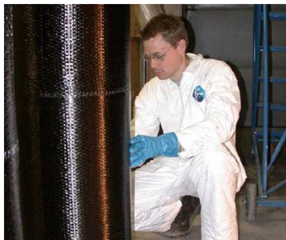
Figure III-6 : stratification au contact
