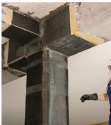
Figure. II-30 Renforcement de la jonction poteau-poutre
