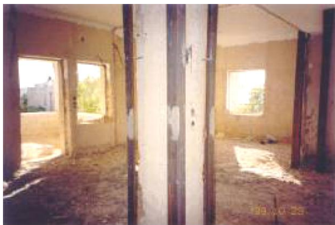
Figure I - 11 : Renforcement de poteaux au moyen de profilés métallique.
