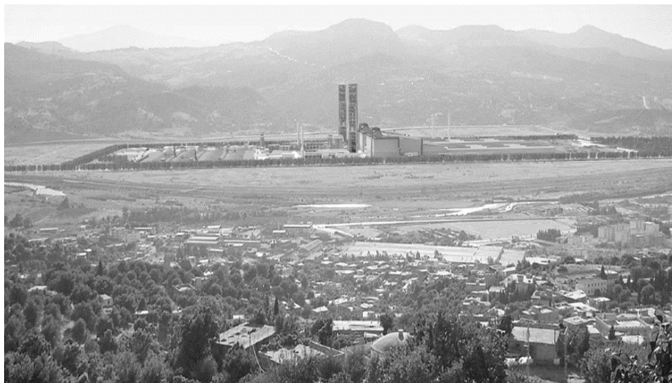
Figure 6: Vue générale du complexe sidérurgique de Ballara. Source : www.jijel.info.dz
